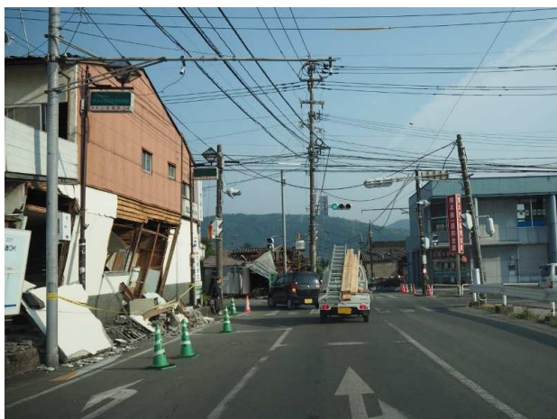
写真2 益城町の家屋被害
