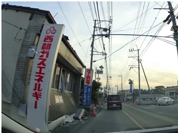
写真1 益城町の家屋被害
